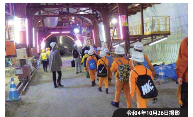
令和4年10月26日撮影 ▲ 現場見学会 (勿来第二小学校、勿来トンネル)
