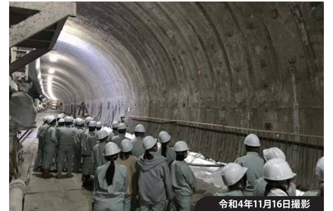
令和4年11月16日撮影 ▲ 現場見学会 (福島工業高等専門学校、勿来トンネル)
